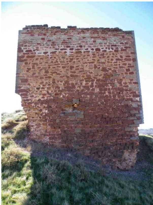
Figura 9.- T9, realizada en Sillarejo 2.
