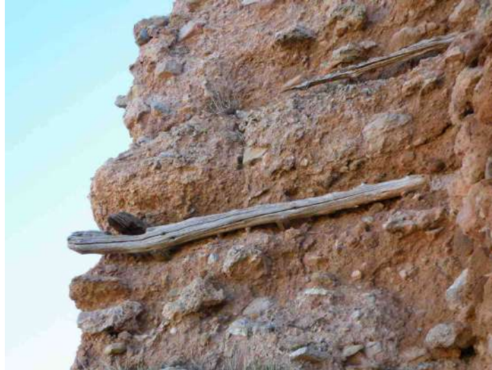
Figura 11.- Detalle sistema refuerzo de los tapiales
