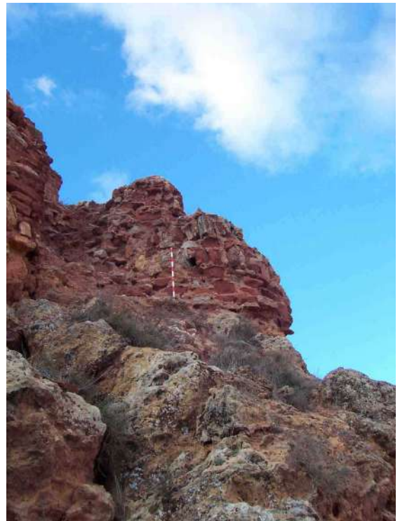
Figura 8.- Vista de la T7, forrada por la Mampostería 3
