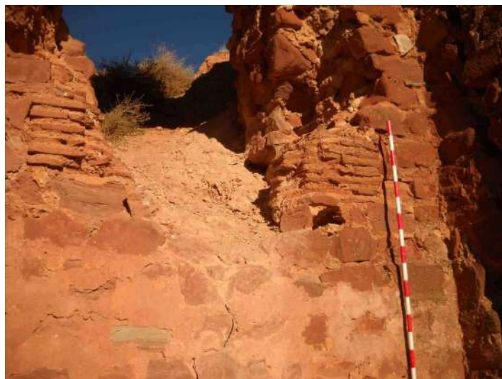
Figura 13.-Vano de la T17 realizado en ladrillo
