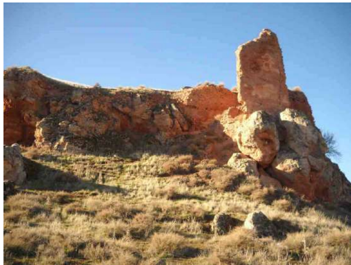
Figura 12.- Vista del frente noreste del Castillo con las construcciones en Tapial 1 y 2
