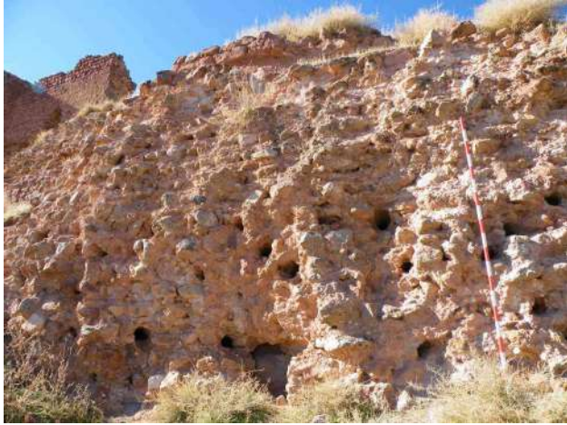
Figura 7.- Toma del frente del L13, realizado en Tapial 3.
