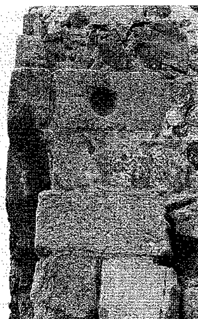
Almonacid (Toledo). A) Muro de tapial del castillo. B) Torre atalaya exenta del castillo.
