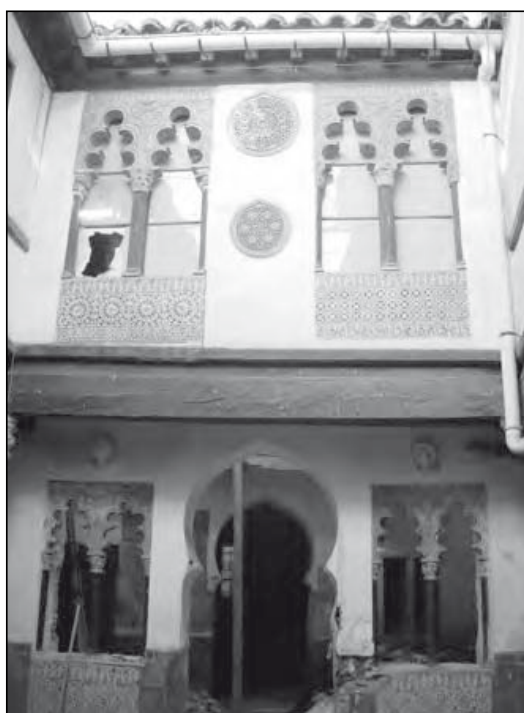
Fig. 1. — Portada historicista de la fachada interior del primer patio (crujía sur).
