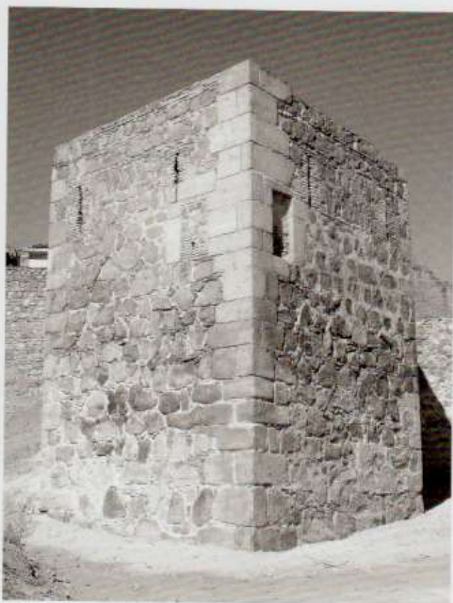
Torreón pentagonal de la puerta Nueva
