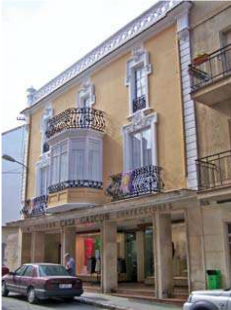
32. Casa de los Gascón en C/ Aniceto Coloma, transformada en el bajo a comercial.
