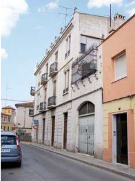
34. Casa de los Arocas en C/ Aniceto Coloma esq. C/ Duque de la Victoria con bajo comercial y accesos diferenciados, en primer plano el de la cochera
