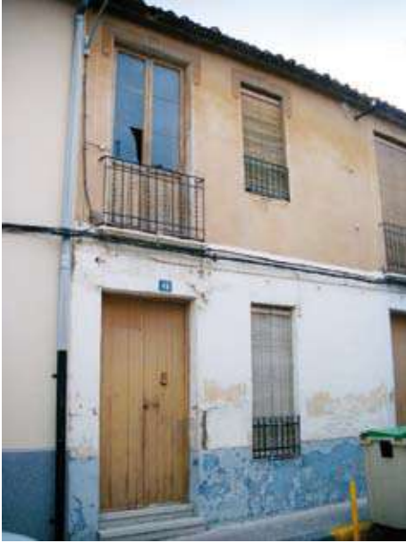
38. Fachada de la vivienda sita en el nº 46 de la C/ Santa Lucía. Aspecto similar a las viviendas de autoconstrucción.
