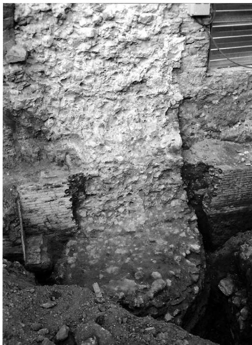
Lámina 2.1.- Cubo de mampostería y encintado de ladrillo descubierto en el subsuelo de la finca número 3 de la plaza de Santo Domingo, 1998. La fotografía está tomada una vez desmantelado el muro de ladrillo del sótano de la vivienda derribada.
